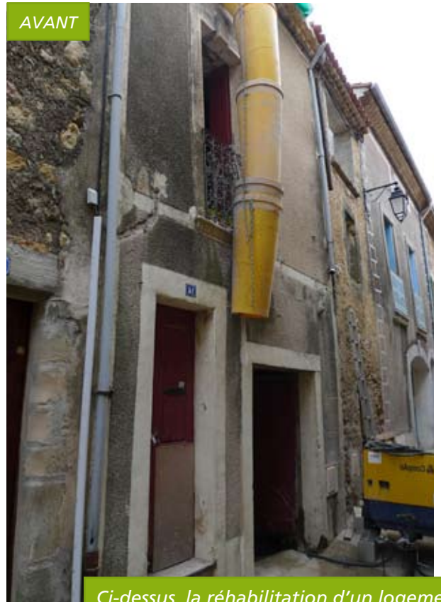
Ci-dessus, la réhabilitation d'un logement communal dans le centre de St-Guiraud
