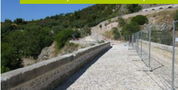
La calade du pont du Diable a été reprise
