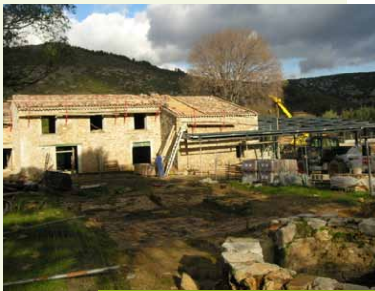
Argileum - la maison de la Poterie prend forme.
