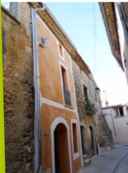
Le logement de St-Guiraud (façade orangée) a été livré à l'automne
