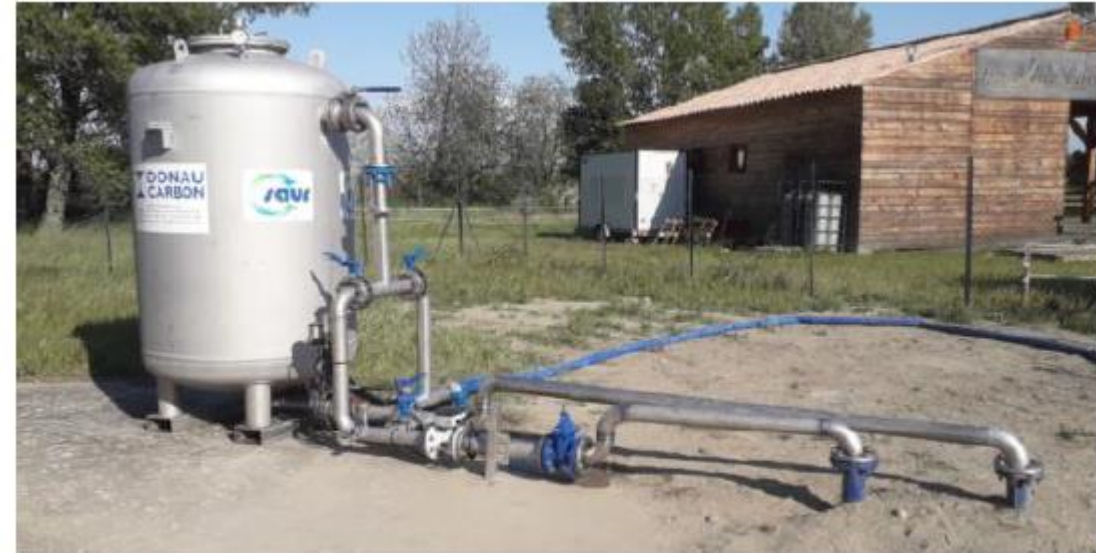
Exemple de traitement provisoire manganèse dans le Gard
