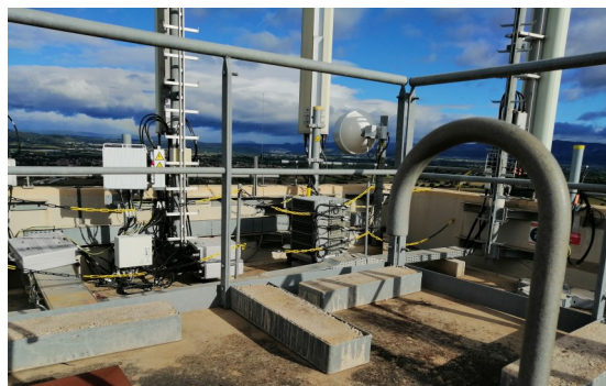
Château d'eau du Pouget
