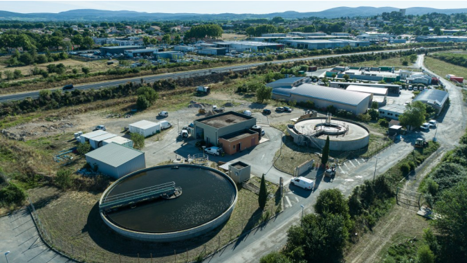
Station d'épuration à boues activées actuelle de Gignac, avant le projet d'extension.
