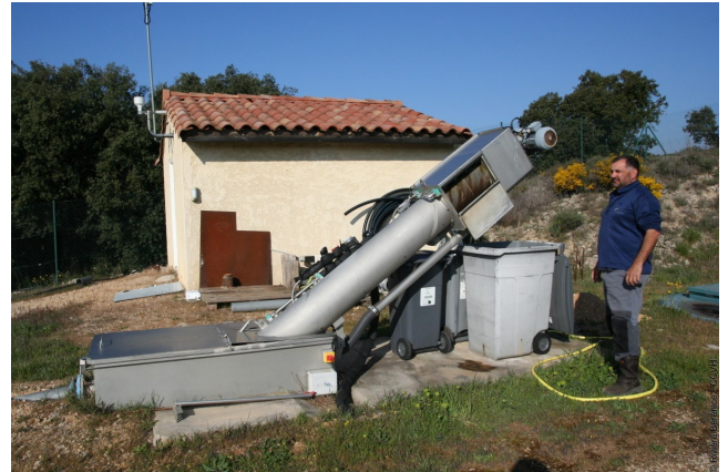
Tamis fin à la station de Montpeyroux
