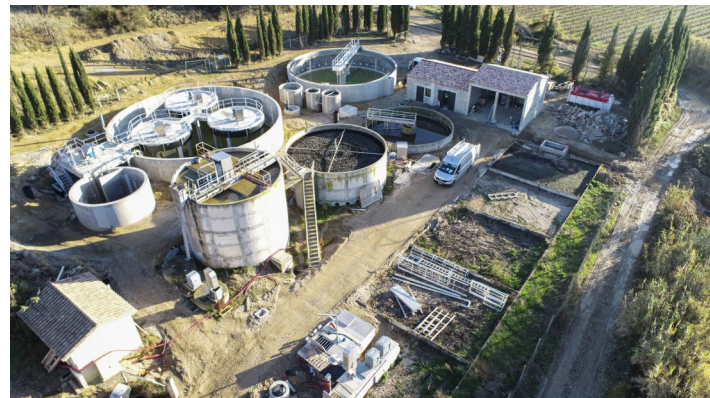
Chantier nouvelle station d'épuration à St Pargoire 2021
