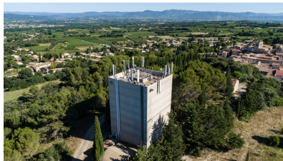
Château d'eau du Pouget
