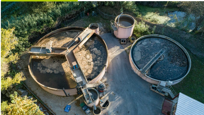
Station d'épuration d'Aniane 2020 ©V Bedos Occidrone-CCVH
