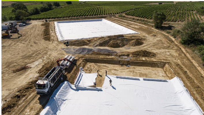
Chantier nouvelle station d'épuration à Vendemian 2019 ©V Bedos Occidrone-CCVH
