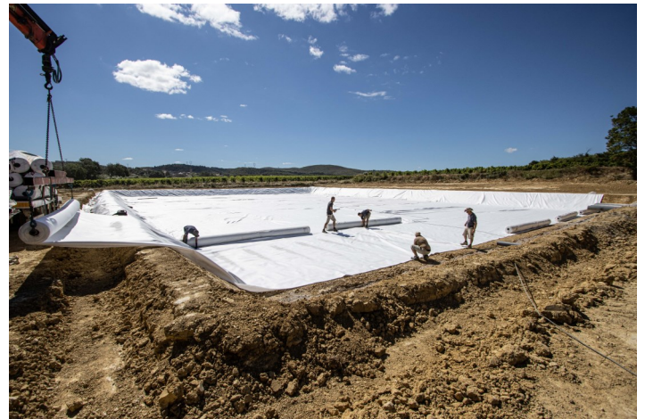
Chantier nouvelle station dépuración à Vendémian 2019 ©V Bedos Occidrone-CCVH
