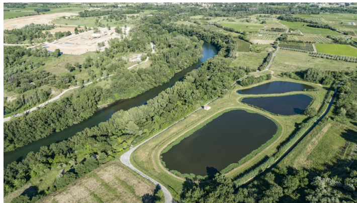
Station d'épuration Lagunes de St Jean-de-Fos 2020 ©V Bedos Occidrone-CCVH
