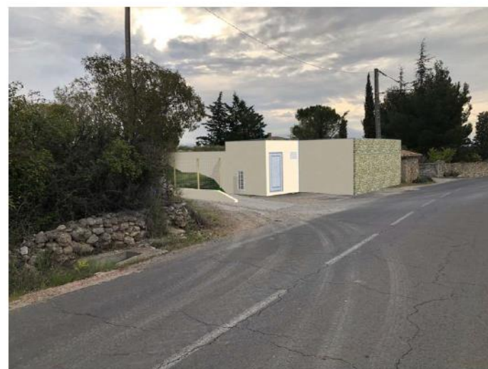
PC 7 / PC 6 - Vue 4 depuis la RD n°9 en direction de Montpeyroux - Après travaux
