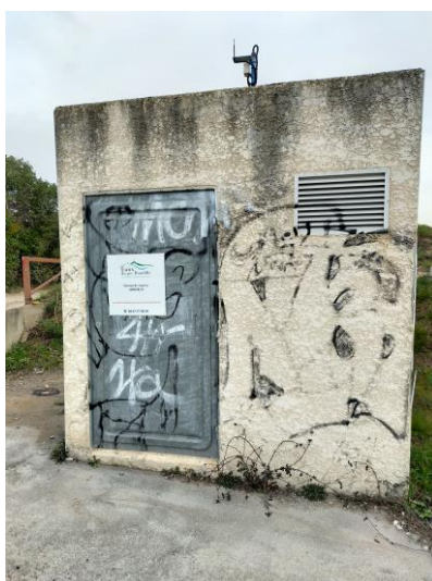
FIGURES 2 - PHOTOGRAPHIES DES OUVRAGES EXISTANTS
