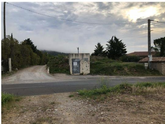
PC 7 - Vue 3 depuis la RD n°9 en direction de Montpeyroux - Avant travaux
