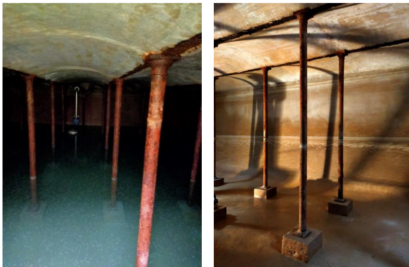
FIGURES 5 – PHOTOS INTERIEUR DE LA CUVE
