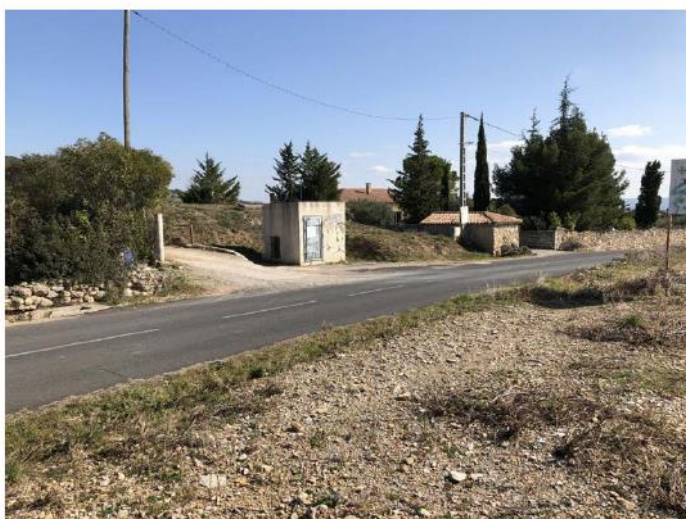
PC 7 - Vue 4 depuis la RD n°9 en direction de Montpeyroux - Avant travaux
