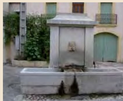
Puits à Puilacher
