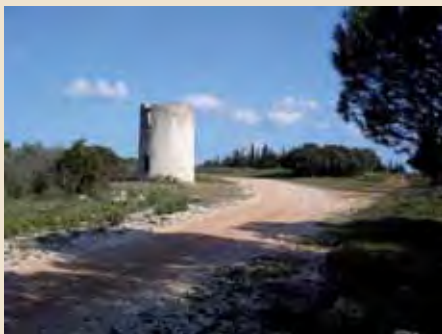
Tour télégraphe de Chappe à Saint-Bauzille-de-la-Sylve
