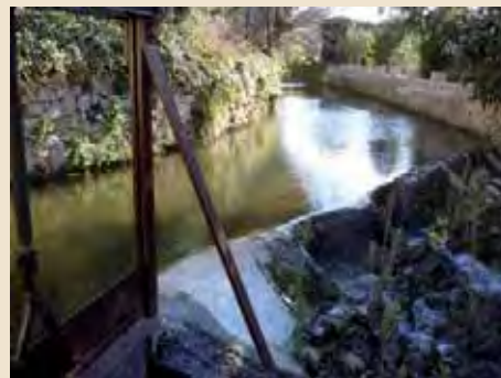
Lavoir à vannes de L'Aurelle à Popian
