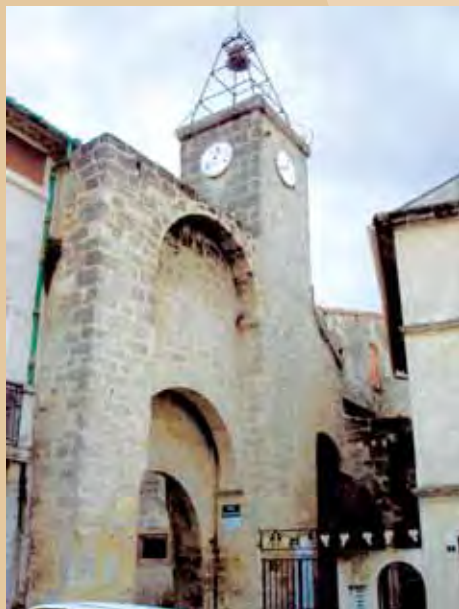
Ouvrage d'entrée, tour à Pouzols
