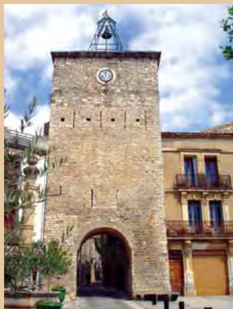
Ouvrage d'entrée Saint-Jean-de-Fos
