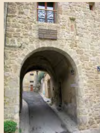
Ouvrage d'entrée à Saint-Pargoire
