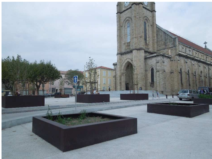
Figure 8 : Aménagement centre ancien, commune de La Grand-Combe - MOE Gilles Amphoux
