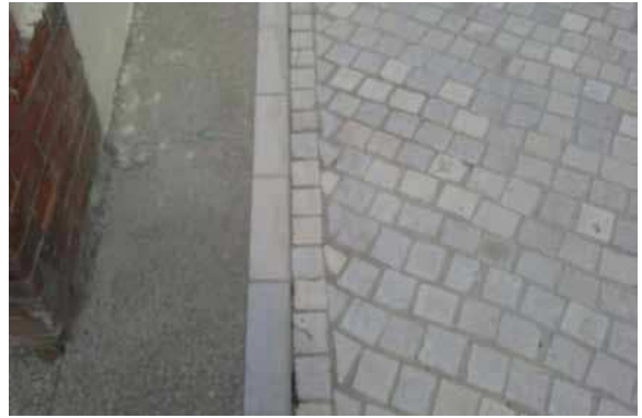
Figure 19 : Exemple de marquages des pies de façades
