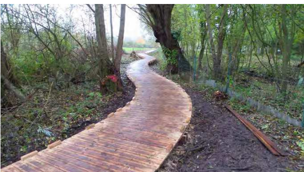
Figures 34 et 35 : Glisy (Somme) - studio d'architecture RANSON / BERNIER restauration et valorisation du marais communal – exemples d'aménagements de circulations piétonnes : caillebotis lorsque le sol est humide et meuble ; grave compactée
