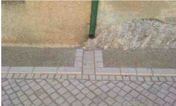
descente de gouttières
