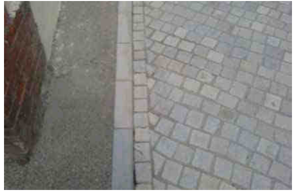
Figure 19 : Exemple de marquages des pies de façades
