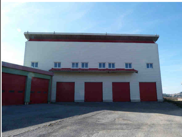
Figure 52 : locaux à aménager à l'entrée du PAE Emile Carles
