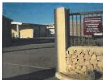
Le service gestion déchets ménagers Chemin de l'Ecosite à Gignac
