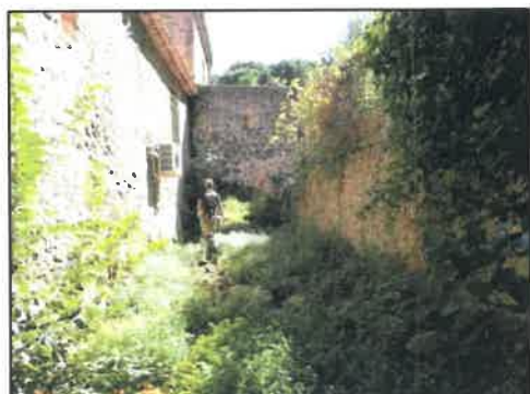
Exemple de situation sur le Lagare), où le risque d'embâcle aurait pu être réduit en débroussaillant les abords de l'ouvrage pour éviter que des arbres ne s'installent
