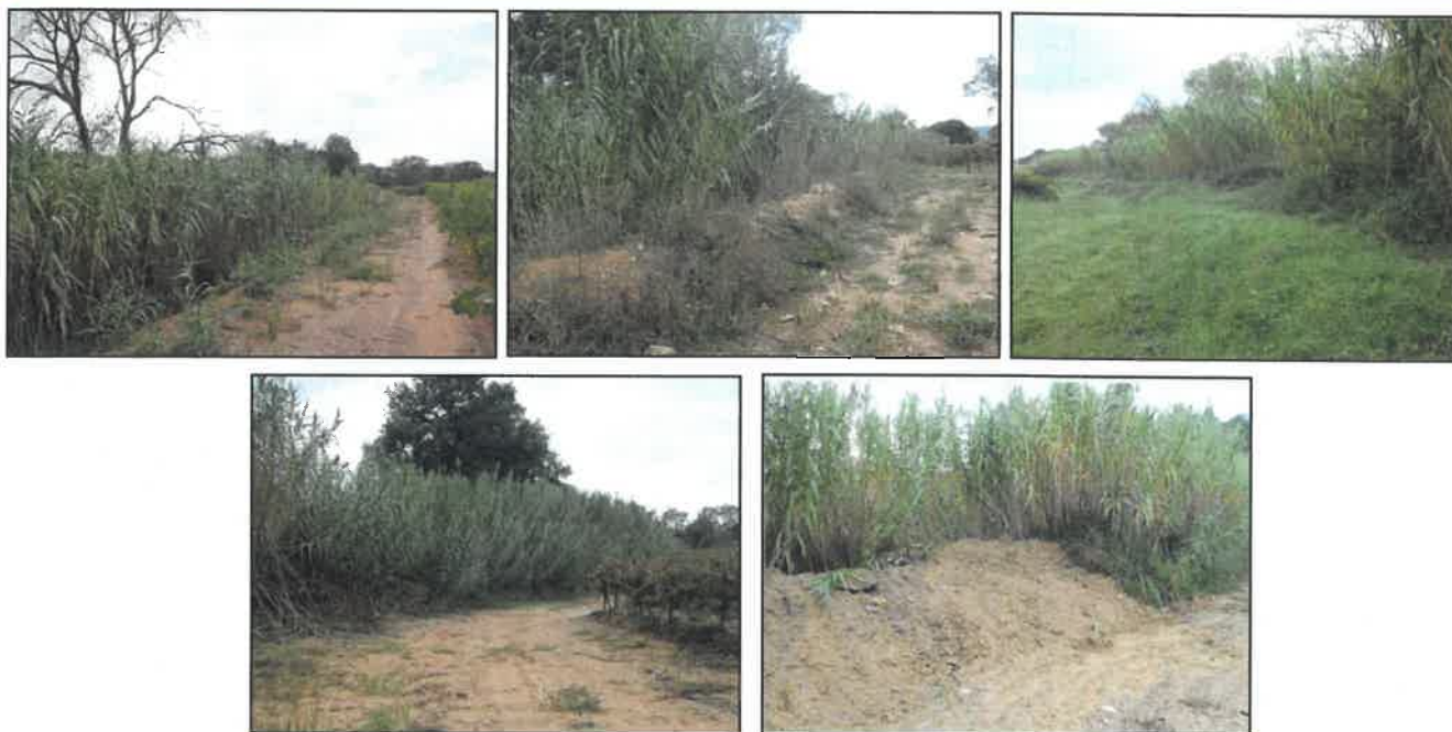
exemple de berges à restaurer par élimination des cannes de Provence, retalutage des berges en pente douce, suppression des merlons de curage et reboisement (Rouvière entre pk 92 et 97)
