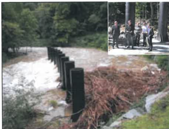
ouvrage filtrant implanté dans un extrados de la Déôme pendant une crue— les pieux sont espacés de 3 m et dépassent de 5 m au dessus du fond du lit pour dépasser de 2.5 m la crue centennale
