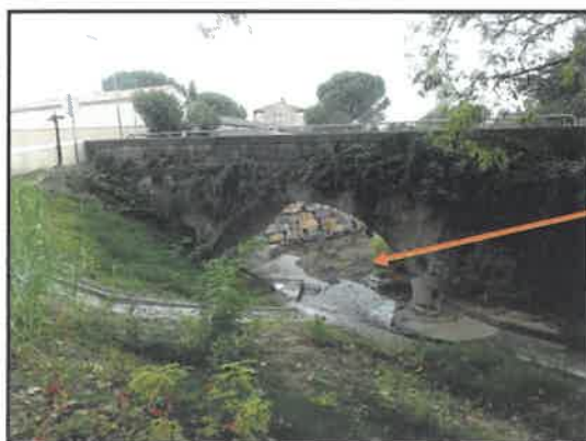
débordement au niveau du pont dans la traversée de Pouzols lors de la crue de septembre 2014—présence d'un embâcle
