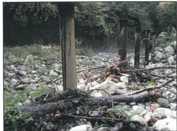
ouvrage filtrant implanté dans un extrados et sur une partie seulement de la section d'écoulement dans le torrent du Sierroz en Savoie 600 m en amont d'un pont— les pieux dépassent de 1 à 2 m au dessus du fond du lit et sont espacés de 2 m
