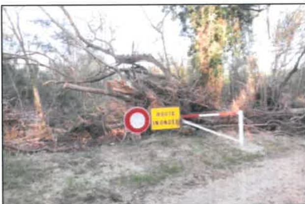
Embâcle suite à la chute d'un arbre en amont d'un pont en 2014 traité en urgence après la crue
