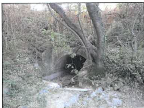
Exemple de situation sur le Lagare), où le risque d'embâcle aurait pu être réduit en débroussaillant les abords de l'ouvrage pour éviter que des arbres ne s'installent
