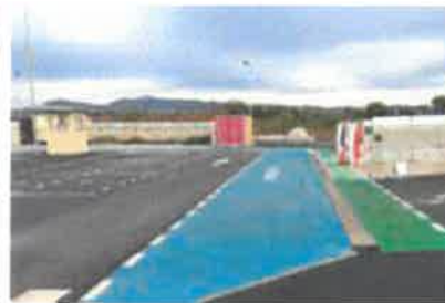
Agrandissement de la déchèterie de Gignac
