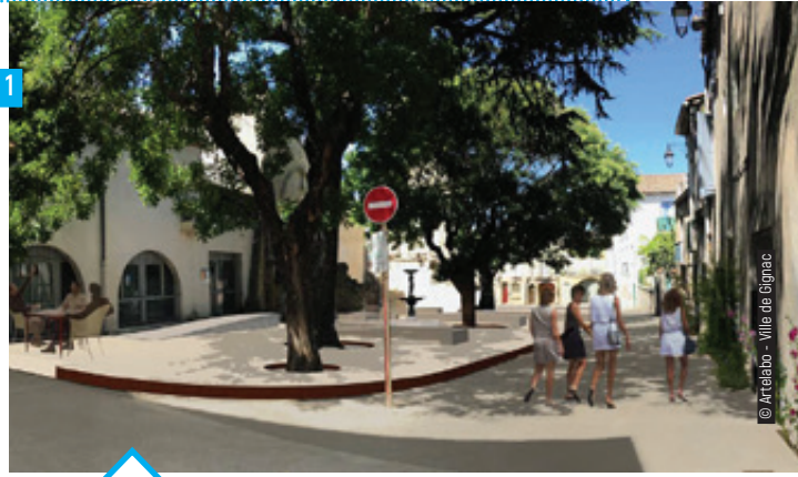
Nettoyage des pierres, reprise des sols et des marches, rénovation de la fontaine et de l'angelot et construction d'un bassin en pierres, installation d'une borne fontaine à boire, éclairage à Led, jardinières et fleurissement sont au programme du chantier du square de la Fontaine à Gignac.
