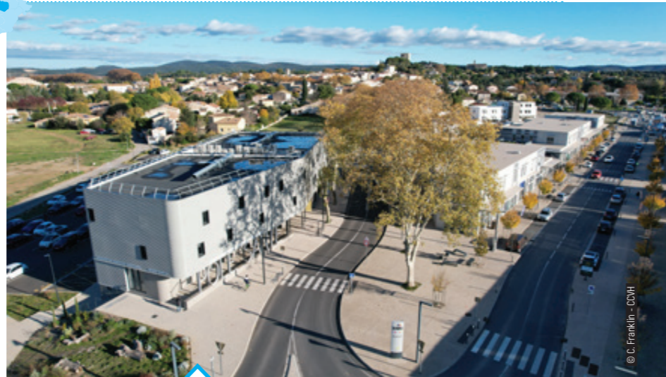
Vue aérienne du Pôle santé et de l'espace commercial Cosmo.
