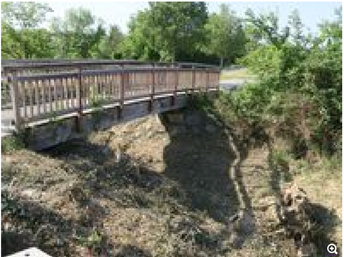
^ Chantier à Montarnaud
