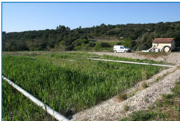
De gauche à droite : filtre plantés de roseaux et tamis fins des eaux usées – Montpeyrroux
