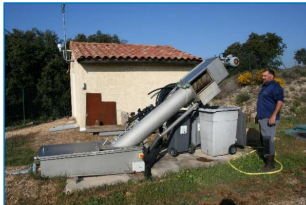
De gauche à droite : filtre plantés de roseaux et tamis fins des eaux usées – Montpeyrroux
