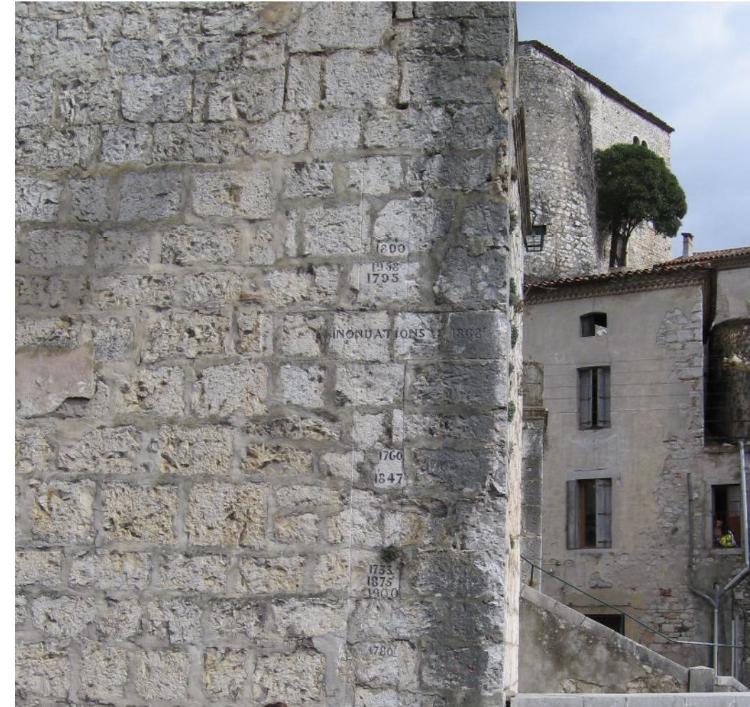
Photo 2 : Repère de crue sur l'église de Laroque.
