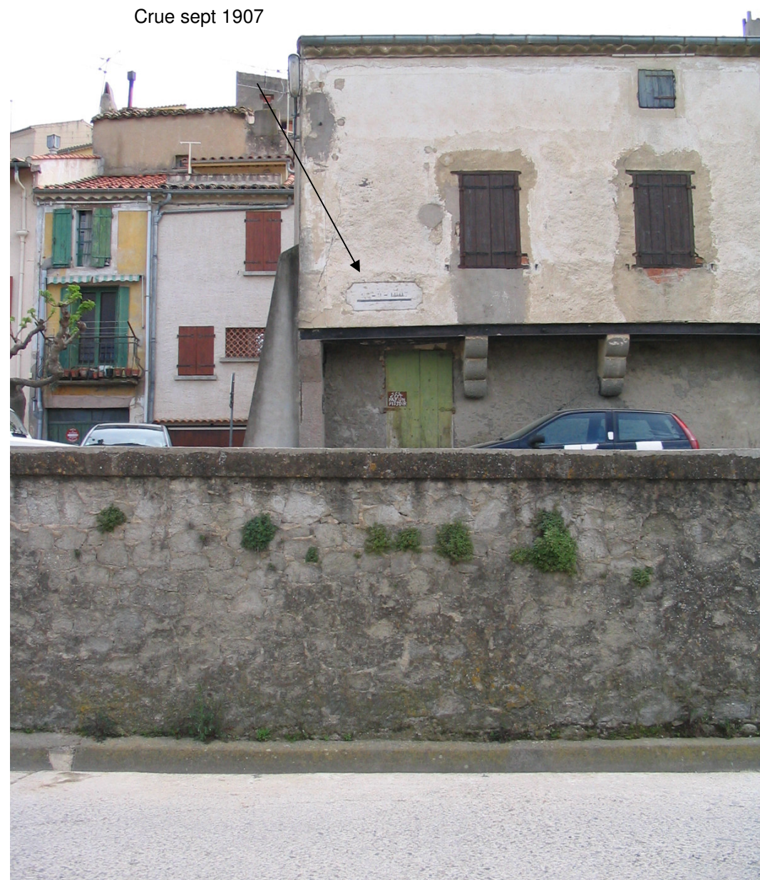
Photo 13 : Repère de crue dans le village
