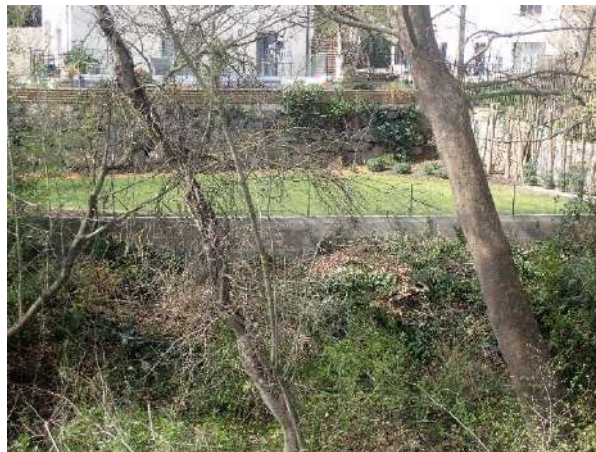
Figure 72 : Premières habitations en rive gauche du ruisseau en amont du pont canal
