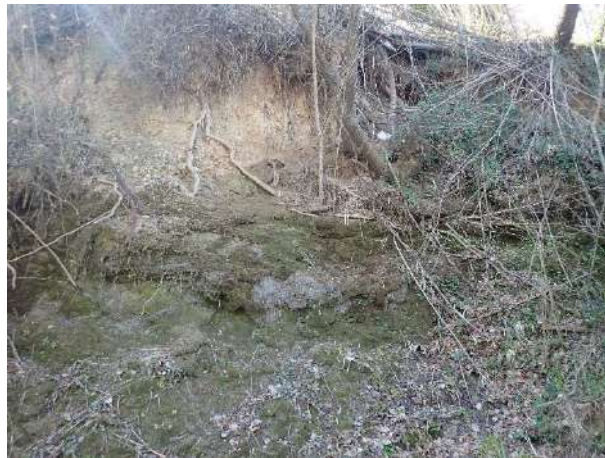
Figure 108 : Erosion du haut de berge rive gauche en aval des enrochements
