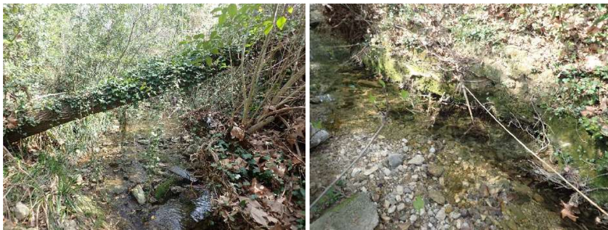
Figure 81 : Lit mineur du ruisseau de Lussac en aval du pont canal.
