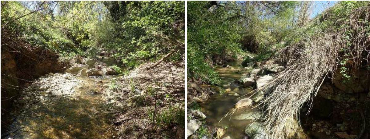
Figure 123 : Berge rive gauche protégée par des enrochements, blocs béton...
