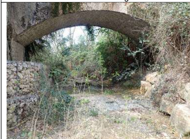
Vue amont du pont
