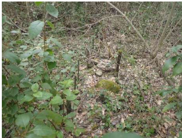
Figure 65 : Ancien mur transversal détruit dans le lit moyen
