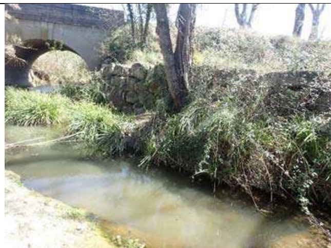
Vue du mur aval rive gauche en enrochements
