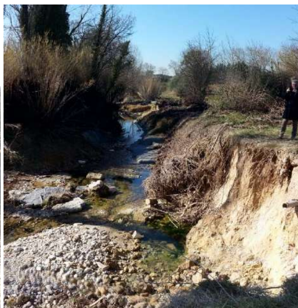
Berges érodées en amont de la station de relevage des eaux usées
