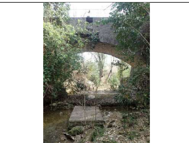
Vue aval du pont
