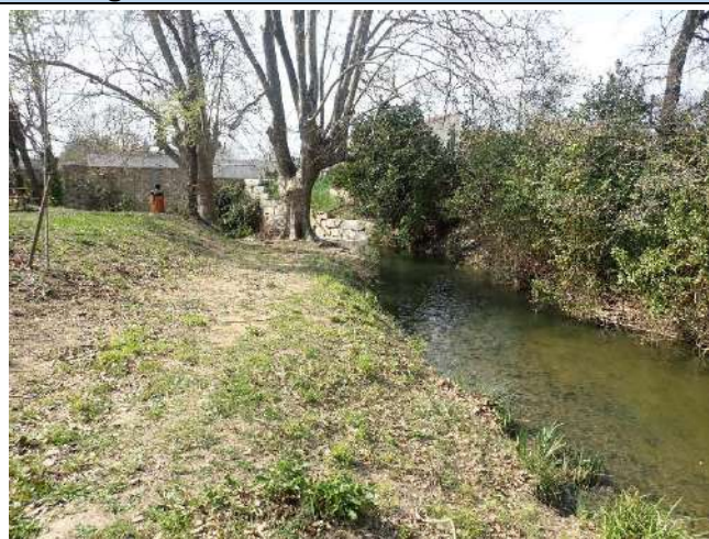
Vue de la retenue et des berges en amont des bassins du lavoir
