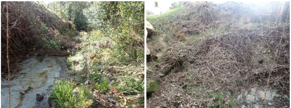
Figure 92 : Affleurement des marnes grises et érosion de berge
