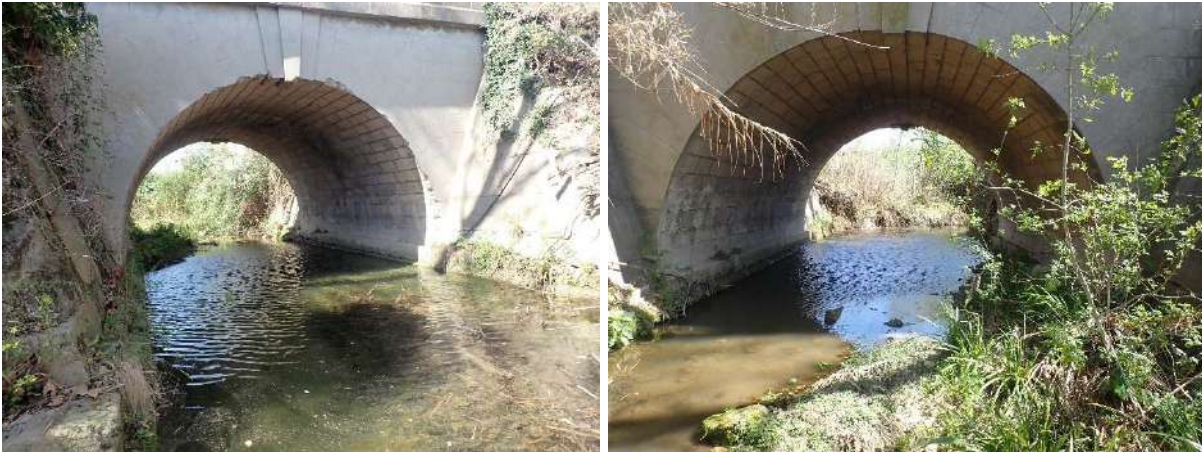
Figure 130 : Vues amont / aval du pont voûté de la RD32
