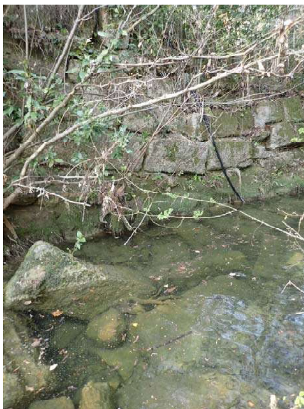
Figure 82 : Mur de grosses pierres obligeant le ruisseau à le contourner
