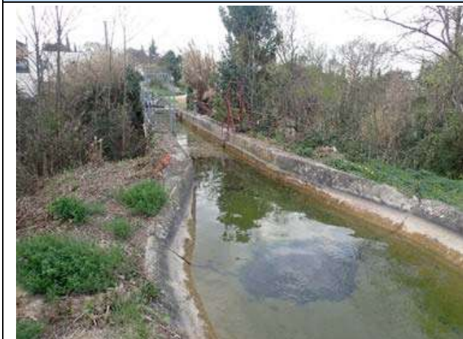
Vue du canal en rive droite
