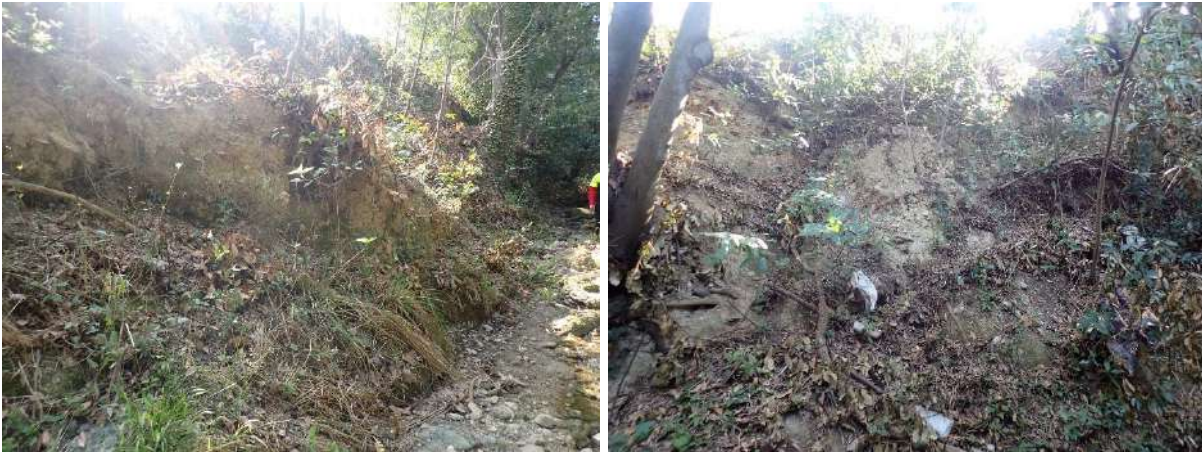
Figure 93 : Erosions de berge sur des talus raides
