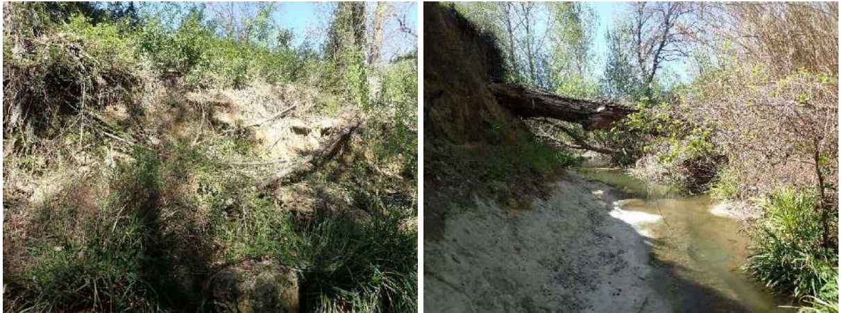
Figure 121 : Arbres tombant dans le lit à cause des érosions de berge
