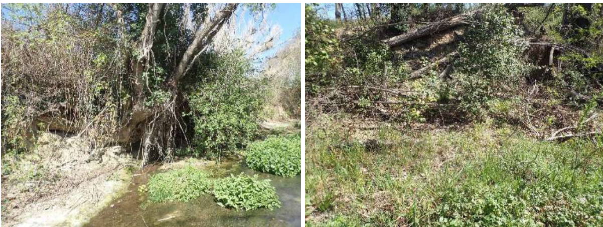
Figure 118 : Arbre instable en extrados de coude et reste d'embâcles sur la berge rive gauche en aval du pont de la route D32
