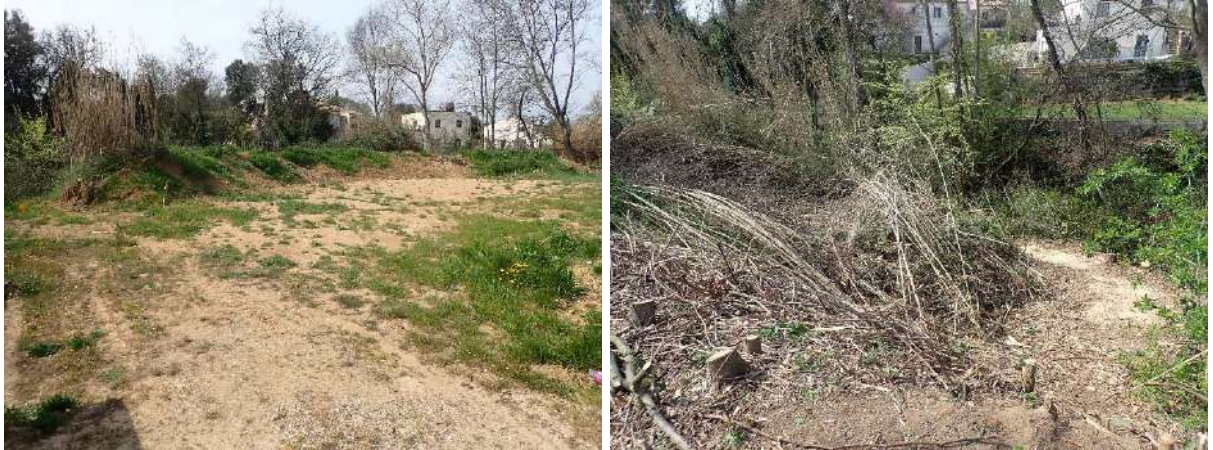
Figure 71 : Merlon de haut de berge rive droite et arbres abattus dans le lit moyen
