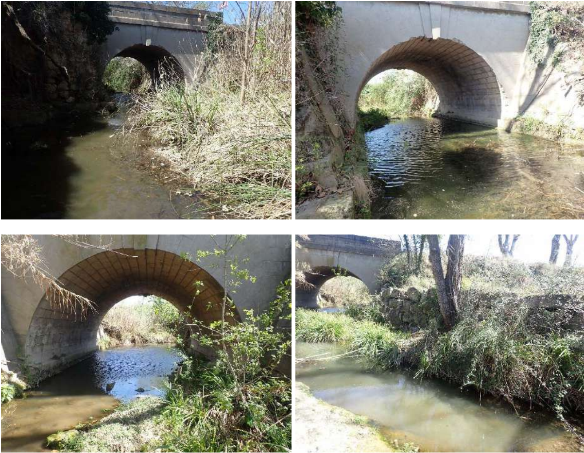
Figure 117 : Pont voûté de la RD32
