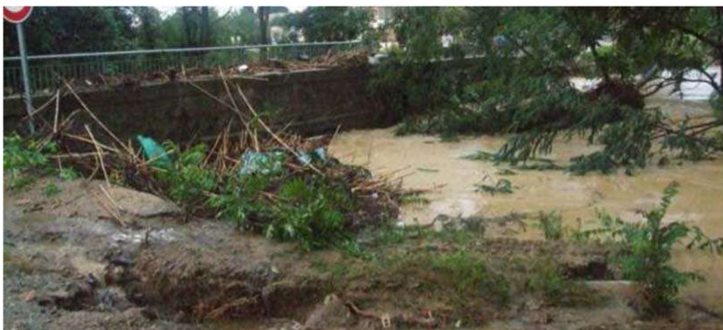
Amont du pont de la RD123 à Pouzols, la décrue étant amorcée (source : Midi Libre)
