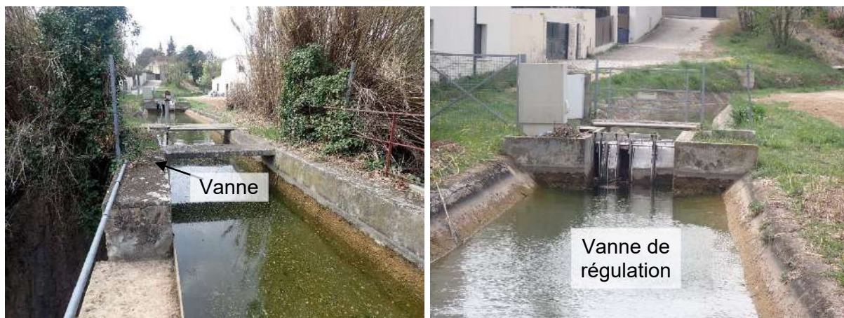
Figure 74 : Organes de gestion du canal d'irrigation aux abords du pont canal du ruisseau de Lussac
