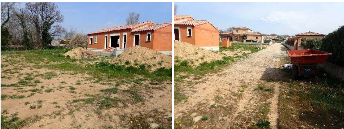
Figure 70 : Habitation en cours de construction en rive droite du ruisseau de Lussac
