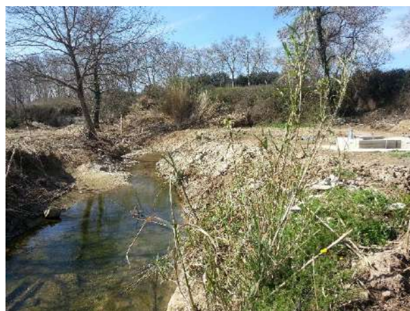
Berge érodée au droit de la station de relevage aval des eaux usées
