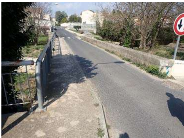
Vue de la chaussée et des parapets
