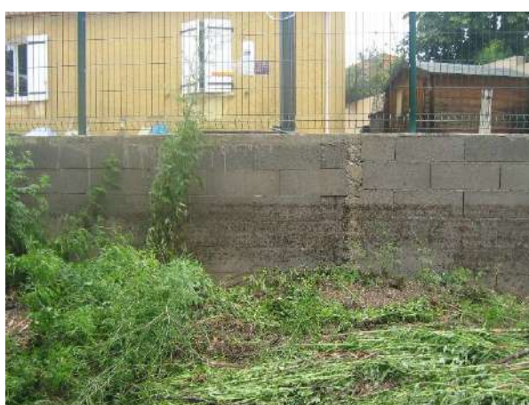
Figure 12 : Laisses de crue au lotissement Lauzes
