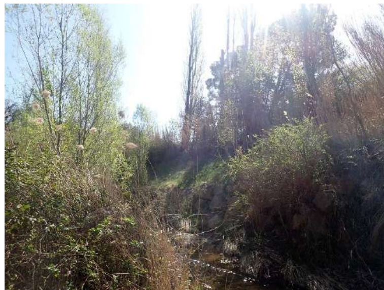
Figure 107 : Massif d'enrochements libres protégeant la berge rive gauche
