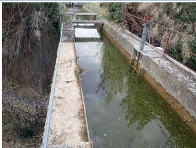
Vue du canal au droit du lit du ruisseau
