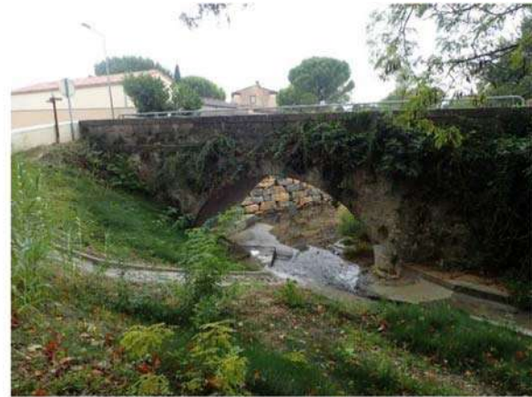
Figure 30 : Le pont près de l'aqueduc renforcé par des matelas de gabions / Le pont de la RD123 embâcle en 2014 (Lussac)
