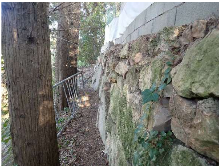
Figure 100 : Enrochements de soutènement d'un remblai en lit majeur rive gauche
