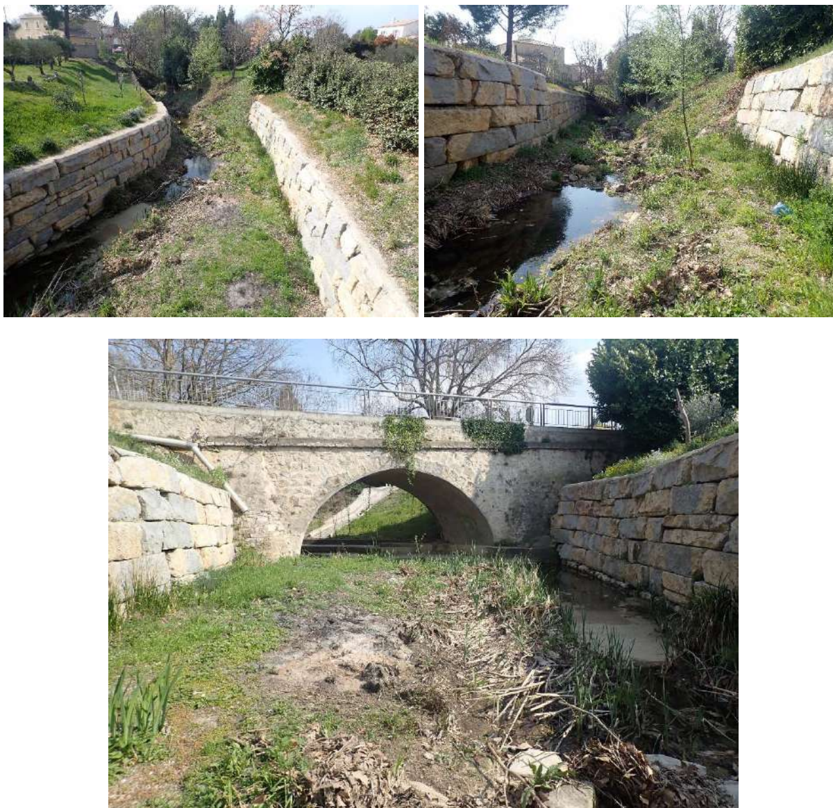
Figure 90 : Murs d'enrochement de protection de berge en aval du pont de la RD123
