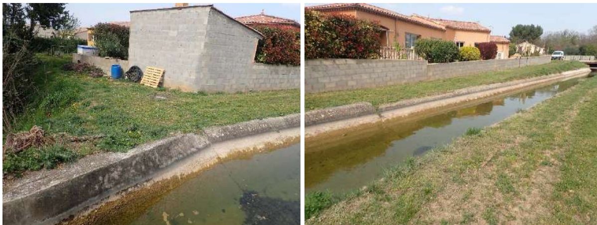
Figure 77 : Murs de propriété en rive droite en aval du pont canal
