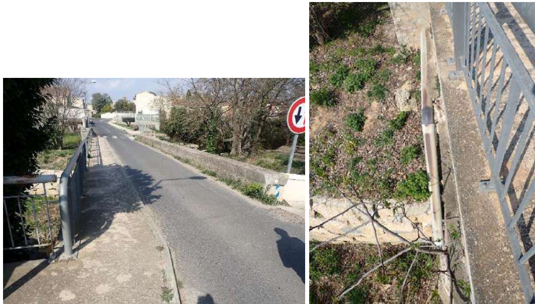
Figure 88 : Vue de la chaussée du pont de la route D123 / Rejet pluvial aval rive droite
