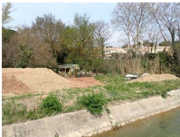
Figure 76 : Remblais dans le lit du ruisseau de Lussac en aval du pont canal
