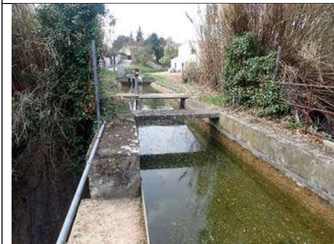
Vue du canal en rive gauche
