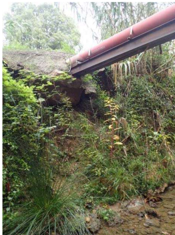
Figure 27 : Conduite apparaissant comme encore très vulnérable à Pouzols (Lussac)
