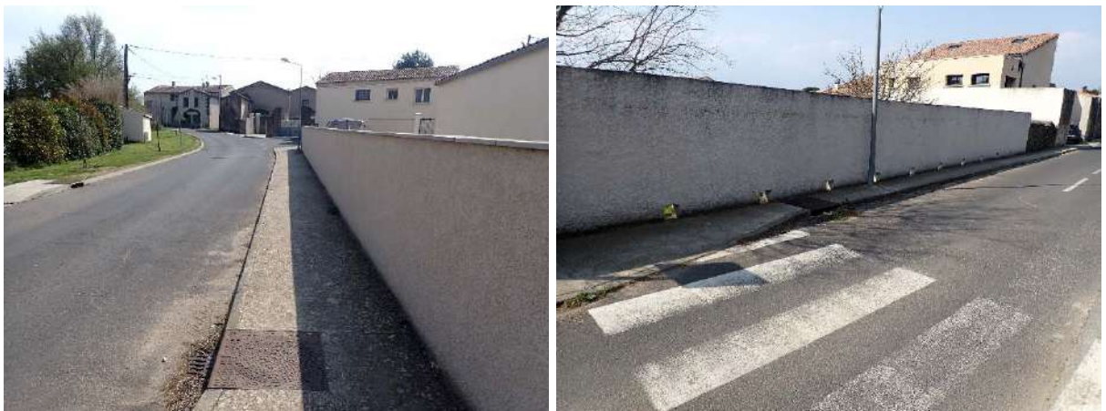
Figure 89 : Murs transversaux de propriété côté aval du pont de la route D123 en rives gauche et droite
