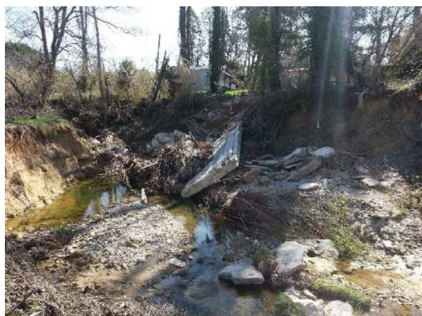
Berges érodées en amont de la station de relevage des eaux usées
