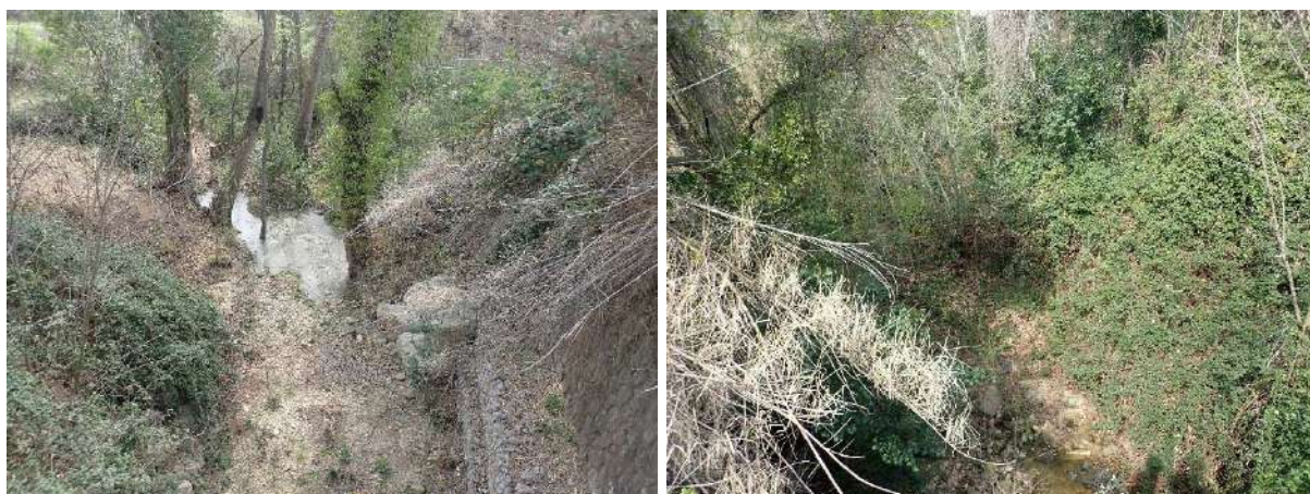
Figure 75 : Vues du lit mineur du ruisseau de Lussac en amont et en aval du pont canal
