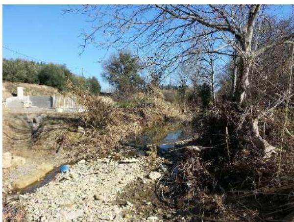
Berge érodée au droit de la station de relevage aval des eaux usées
