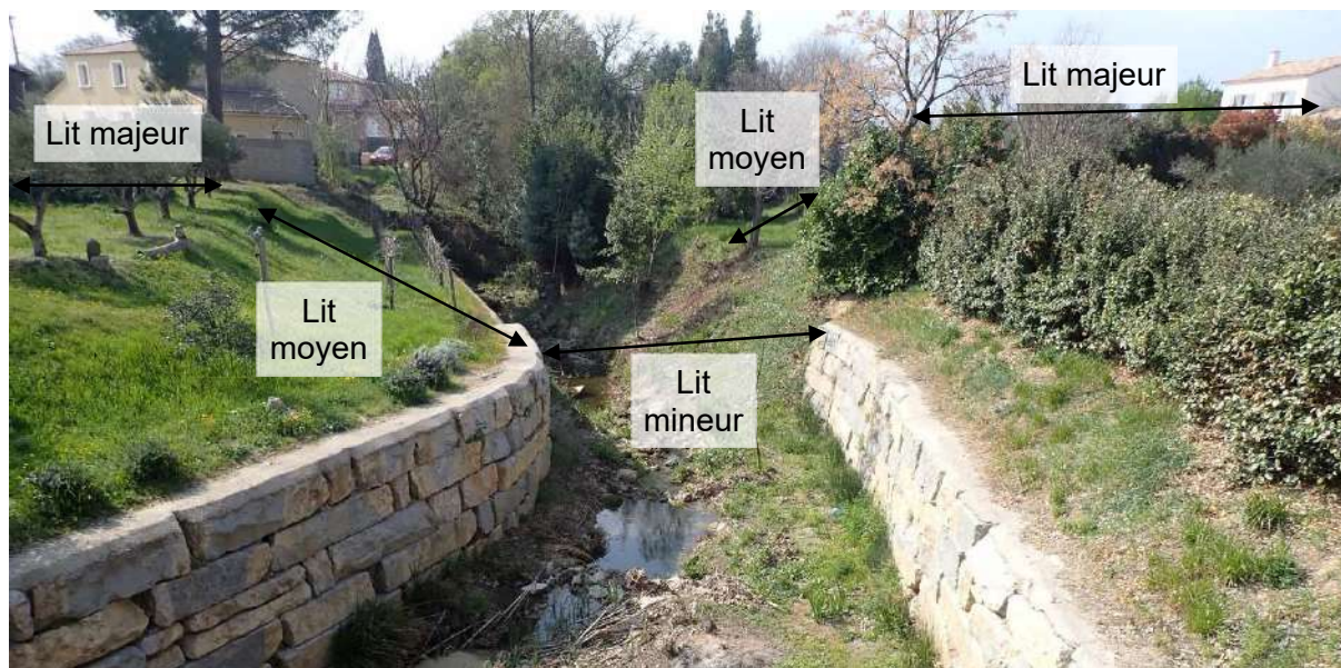
Figure 128 : Lits du ruisseau de Lussac en aval du pont de la RD123
