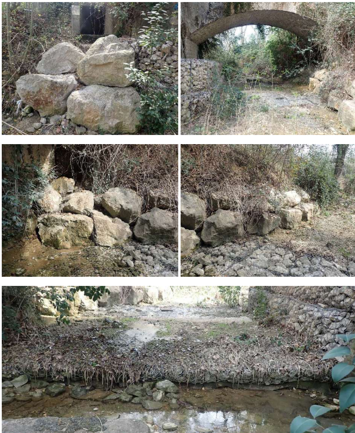
Figure 79 : Protections contre l'érosion sous le pont canal
