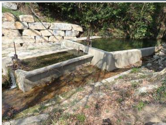
Vue des bassins du lavoir
