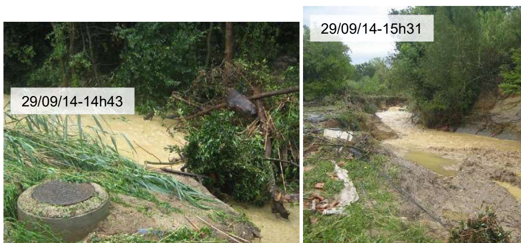
Figure 14 : Conduite EU traversante et terrain rive droite situé entre le village et la station de relevage
