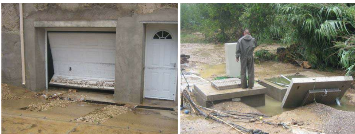
Dégâts provoqués par le débordement du Lussac au-dessus du pont de la RD123, avenue du Pouget / Poste de relevage endommagé par la crue
