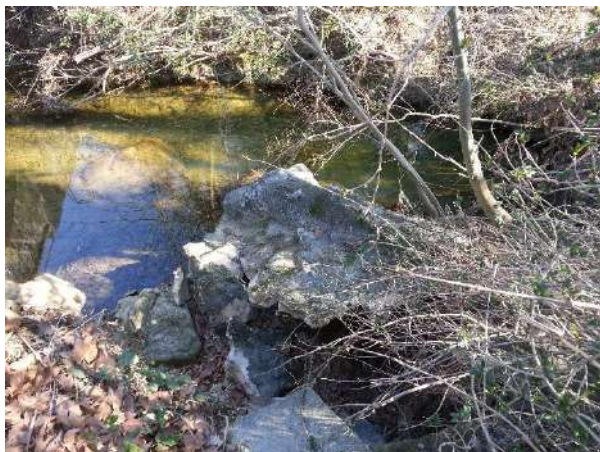
Sortie de la décharge du pont canal côté amont
