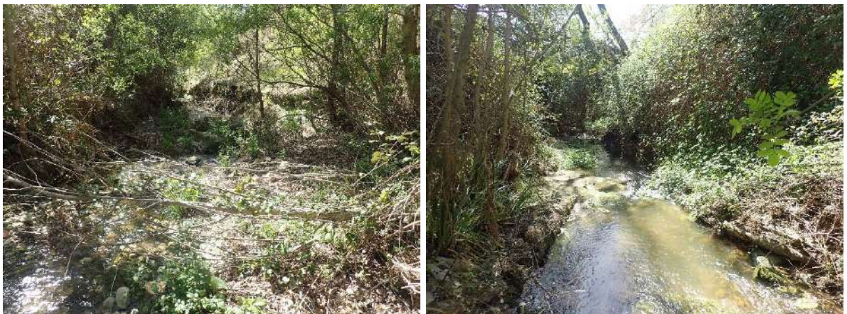
Figure 122 : Revégétalisation du lit avec talus de berge moins raide
