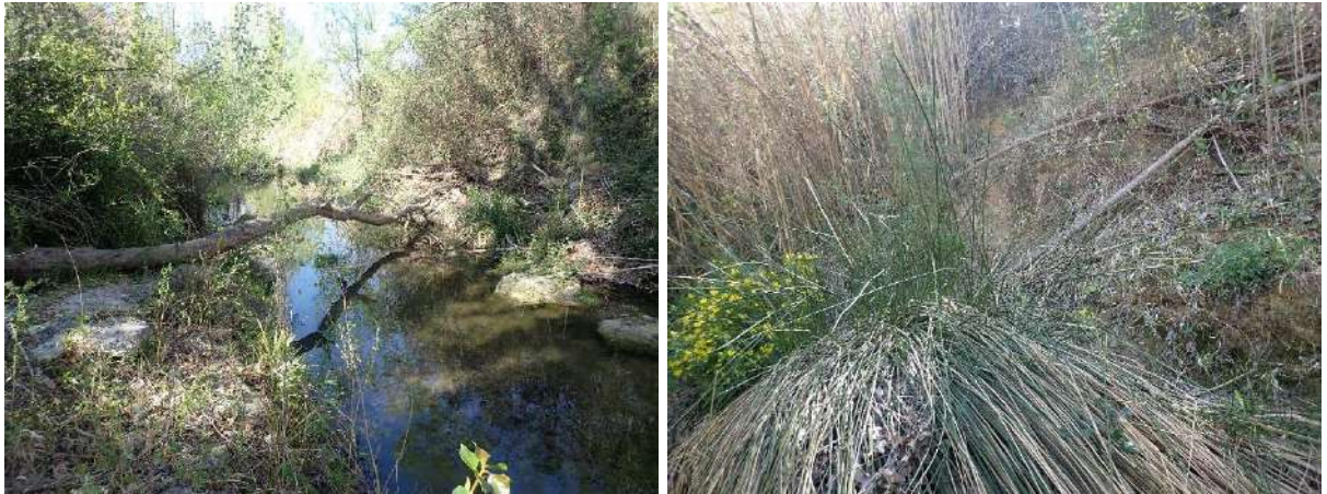
Figure 106 : Arbre mort dans le lit et érosion de berge sur talus raide
