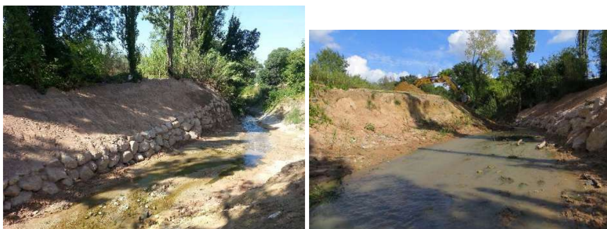
Figure 17 : Photos de travaux d'aménagement post-crue 2014, CCVH
