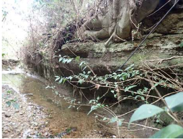
Figure 97 : Systèmes racinaires à surveiller ou arbre mort à retirer en raison d'un risque d'instabilité
