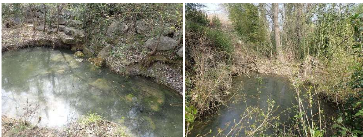
Figure 78 : Fosses de dissipation et enrochement de berge en amont du pont canal
