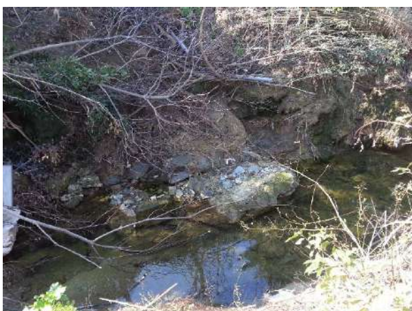
Berge du lit érodée en partie aval du village
