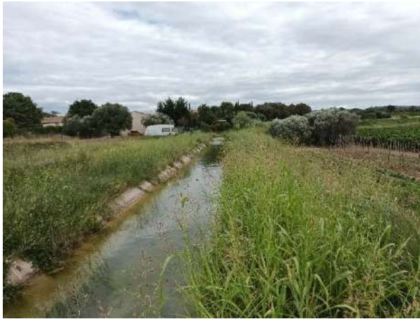
Figure 7 : Photos du canal d'irrigation dans la traversée du bassin versant du ruisseau de Lussac
