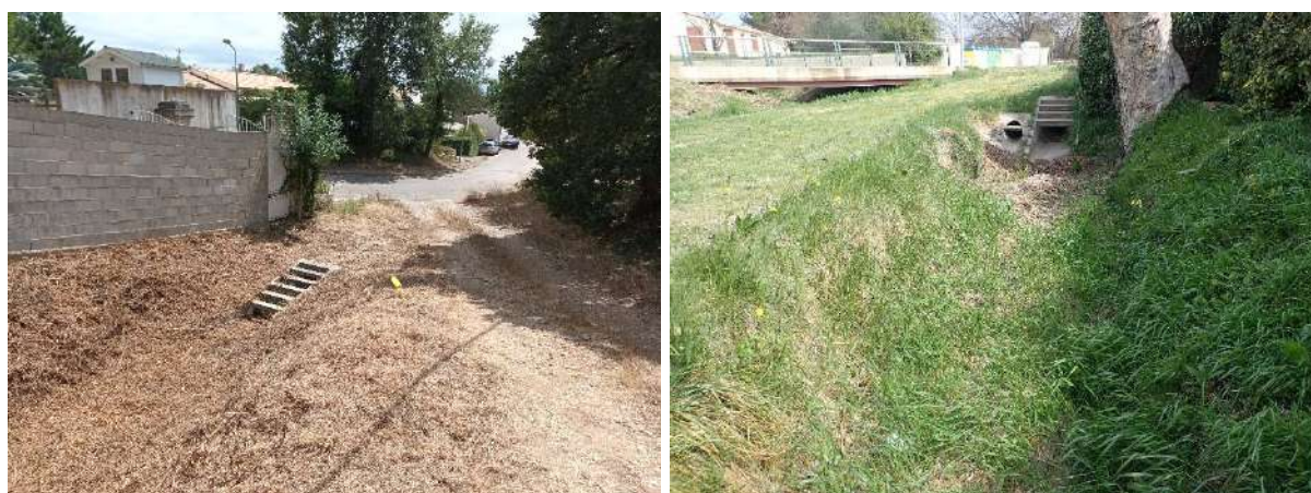
Figure 12 : Entrée / sortie du réseau enterré du Valat de Janelle
