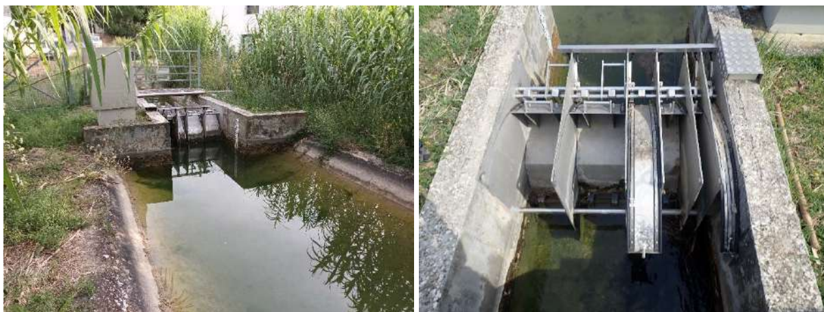
Figure 46 : Vues de la vanne de régulation du canal d'irrigation
