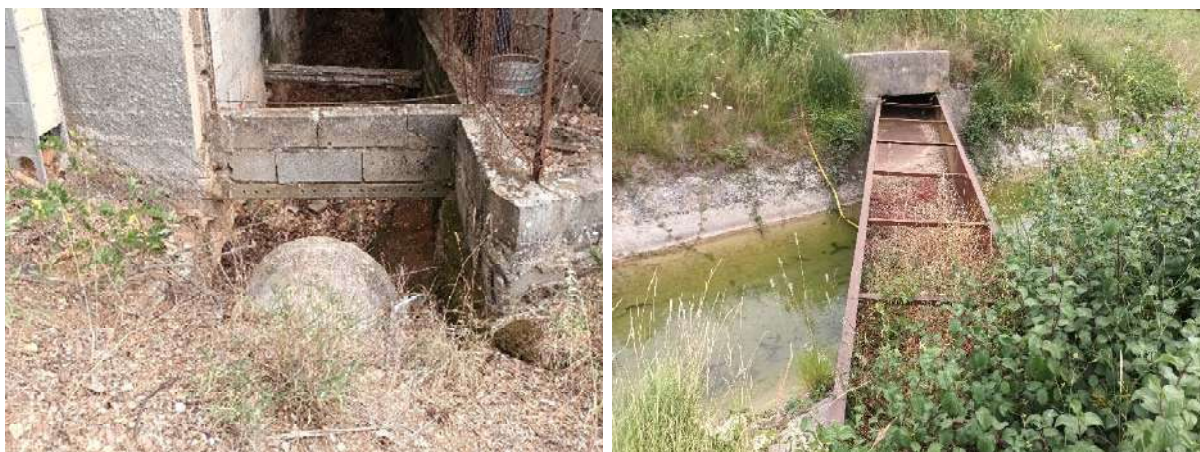
Figure 21 : Vues des ouvrages OHb (buse) et OHc (rectangulaire en acier) de la partie amont des Aiguillères
