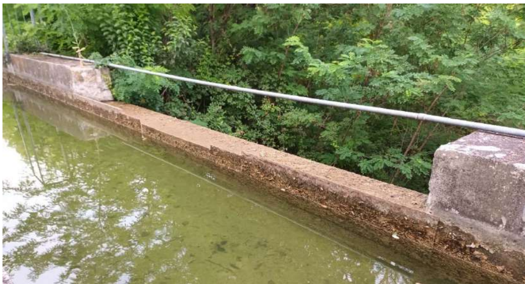
Figure 47 : Vues du déversoir latéral du canal d'irrigation au dessus du lit mineur du ruisseau de Lussac
