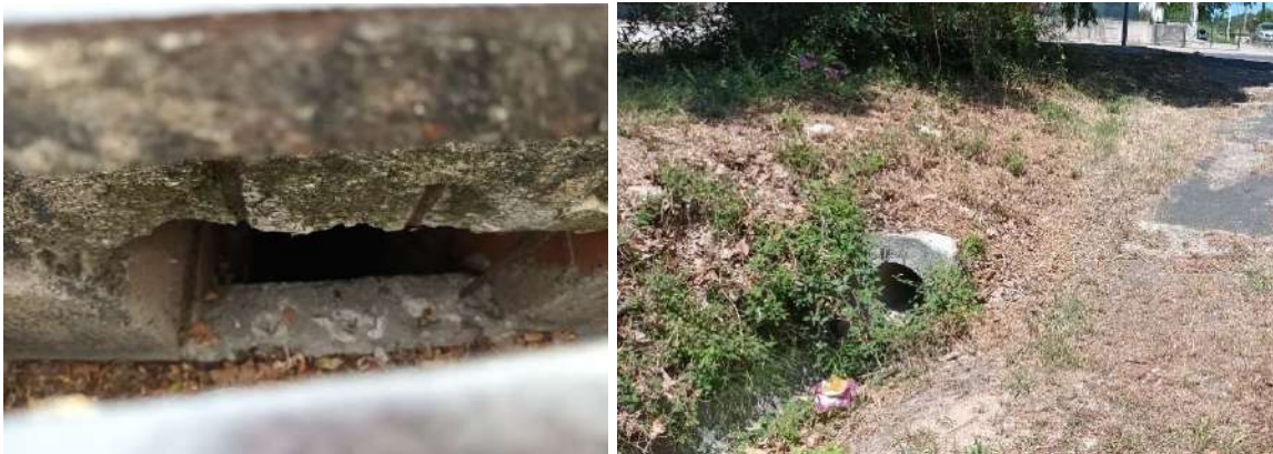
Figure 16 : Vue de l'orifice amont d'entrée dans le réseau enterré au niveau du bas de l'Avenue de Canet / Sortie du réseau enterré vers le ruisseau de Lussac en aval de la rue des Lauzes
