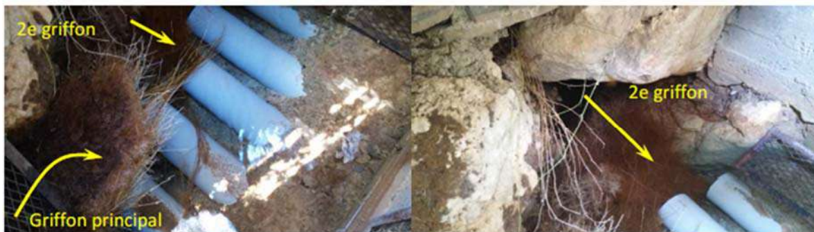
Figure 9 : Chambre de captage
