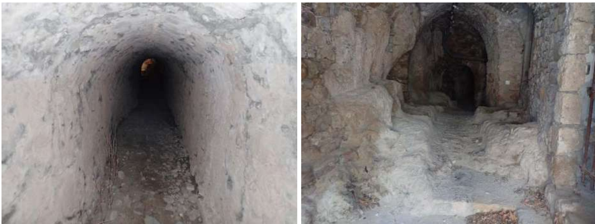
Figure 64 : Axe secondaire en rive droite
