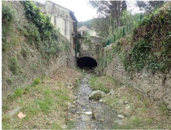
Figure 54 : Lit à ciel ouvert entre murs de berge et partie médiane voûtée
