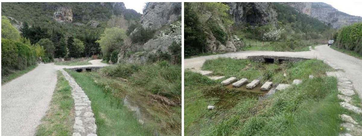
Figure 49 : Ouvrage double cadre et pas japonais en entrée de Saint-Guilhem et au droit d'un étranglement rocheux de la vallée
