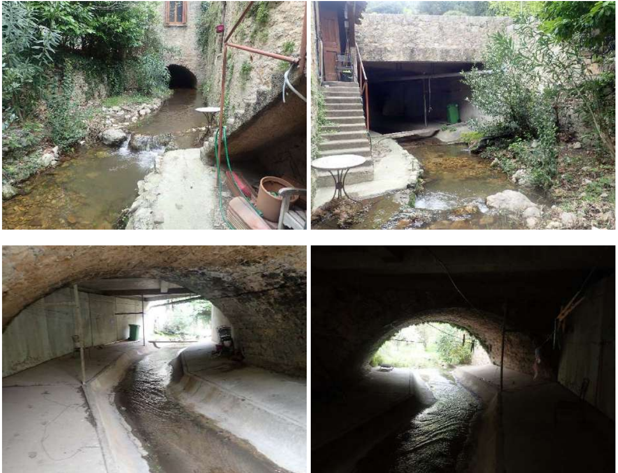
Figure 56 : Ouvrages avec cunette centrale sous la rue menant à la Place de la Liberté
