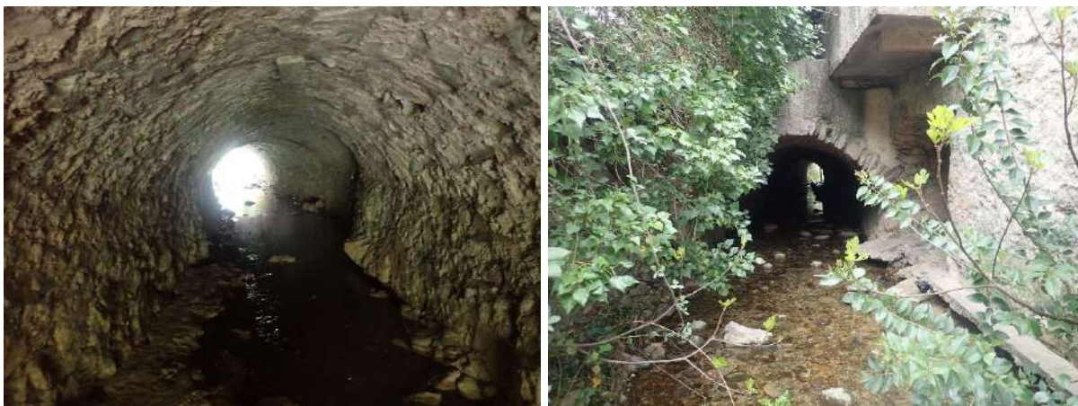
Figure 52 : Tronçon souterrain amont
