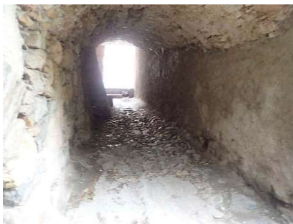
Figure 53 : Connexion aval du lit avec la rue du Bout du Monde
