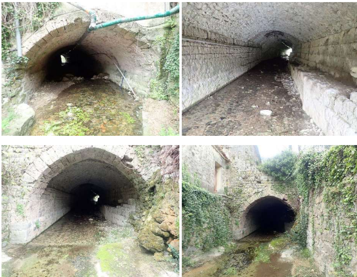
Figure 58 : Tronçon voûté sous l'Abbaye de Gellone
