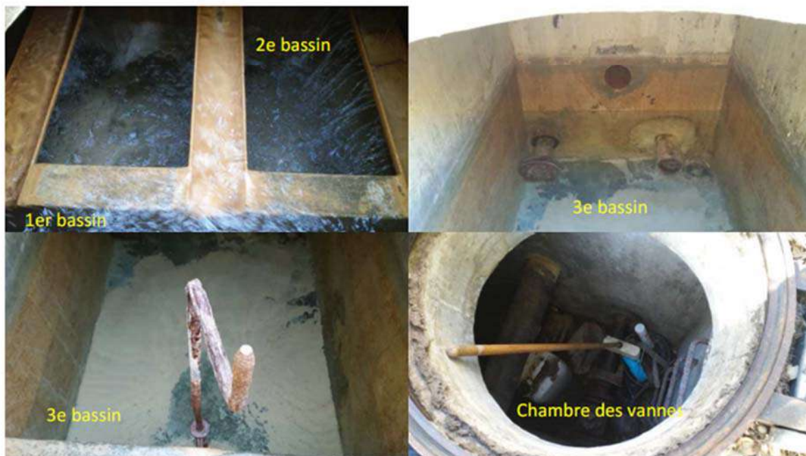
Figure 10 : Ouvrage de réception
