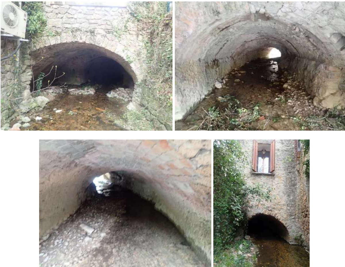
Figure 55 : Tronçon souterrain voûté en partie aval du parking amont
