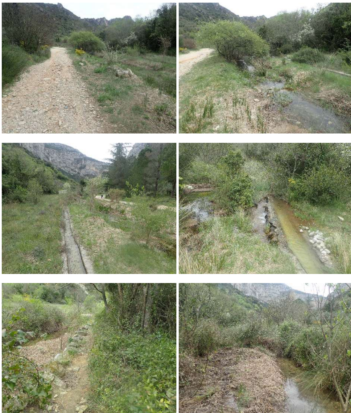
Figure 40 : Seuil et cunette alimentant un ancien canal d'irrigation rive droite
