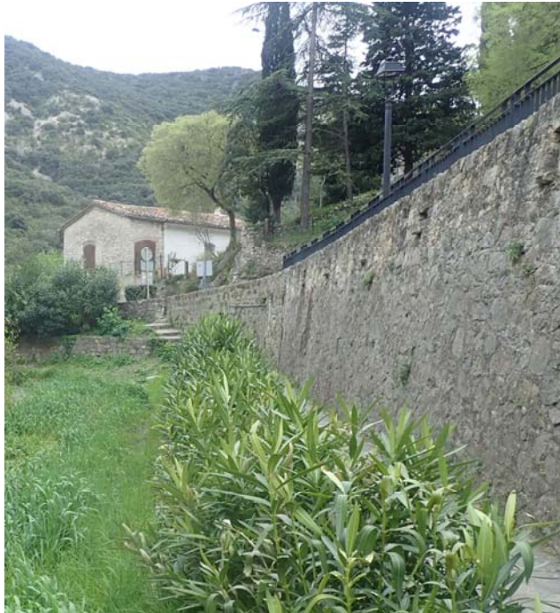
Figure 59 : Vue du mur de berge rive droite sous le parking de la mairie
