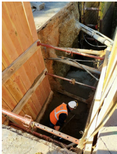
Renouvellement de réseaux ©S Racanière CCVH
