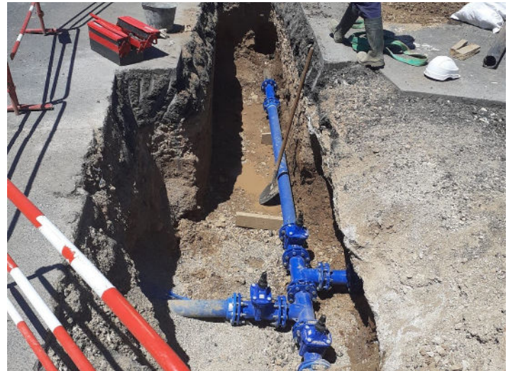
Renouvellement de réseaux @S Racanière CCVH
