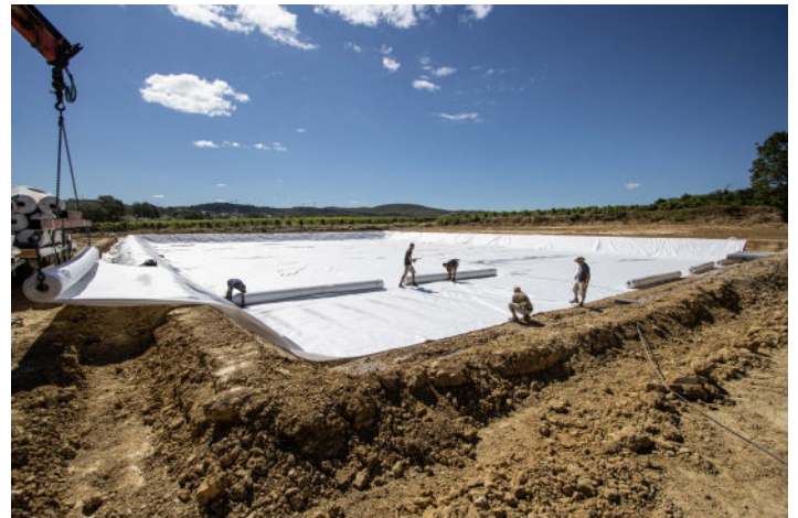
Chantier nouvelle station dépuraton à Vendémian 2019 @V Bedos Occidrone-CCVH
