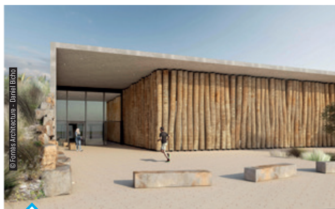
Halle des sports de Gignac : 2 555 m 2 dédiés aux scolaires du territoire, à l'accueil de compétitions et aux associations sportives Gignacoises.
