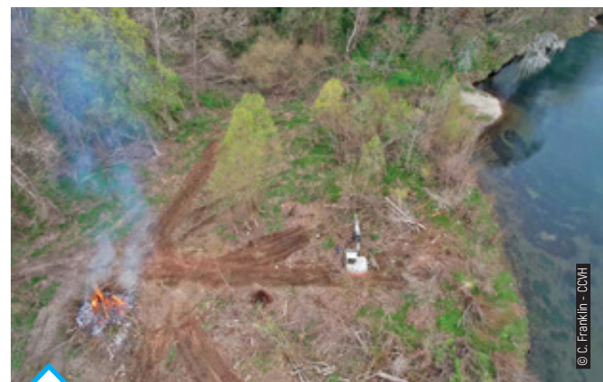
Chantier de restauration du fleuve Hérault et écobuage à Saint-André-de-Sangonis, mars 2022.
