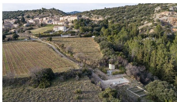
Station d'épuration d'Arboras
