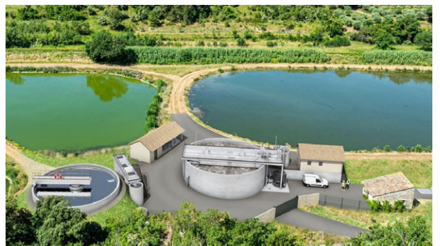
Station d'épuration de Saint-Jean-de-Fos
