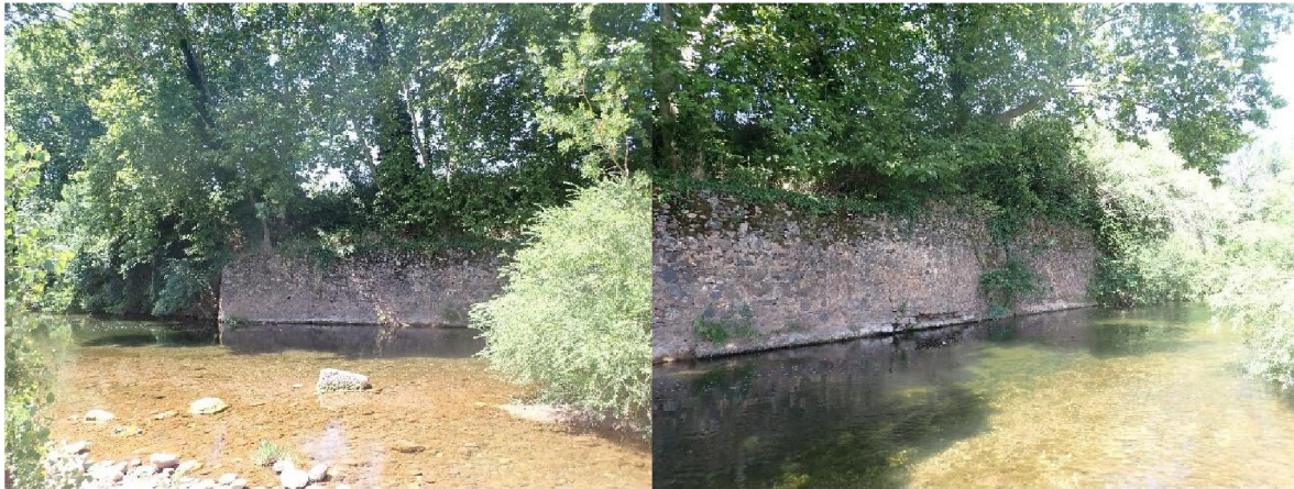
Vue du mur rive droite
