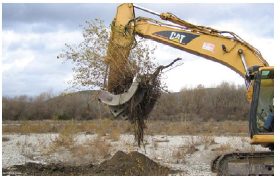
Figure 24 : Travaux d'essartement à la pelle au godet Fleco (source : La gestion de la végétation dans le cadre de la compétence GEMAPI, AFB, 2024)
