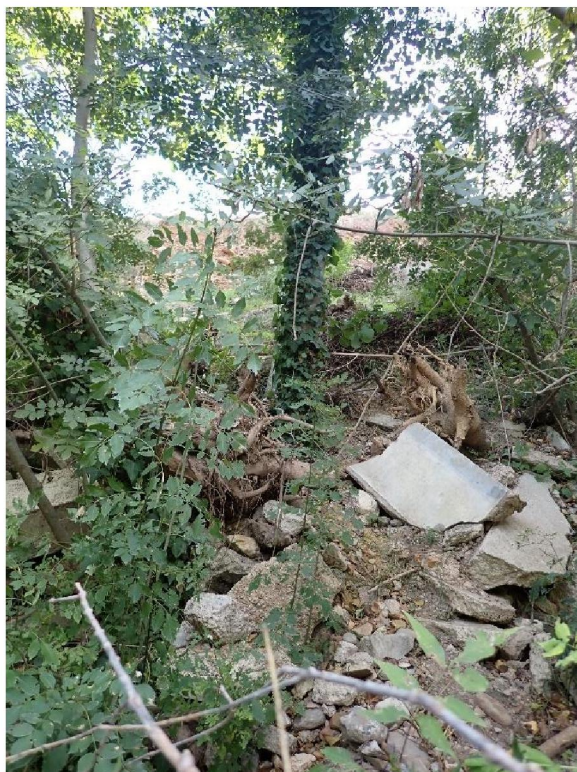
Dépôt de béton en amont du seuil de Mas de Mare (ID26)
