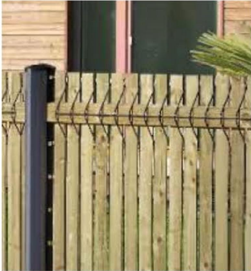
Panneaux rigides en bois intégrés à la clôtures
