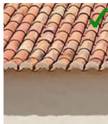
Débords de toiture à l'égout
