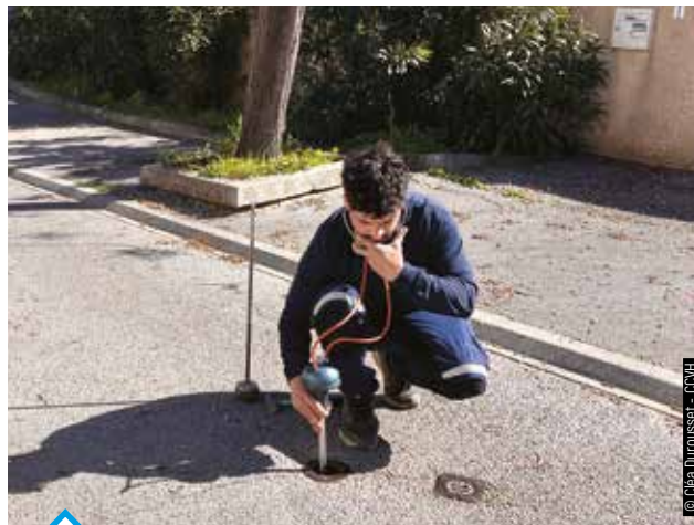
Alexandre traque les défaillances du réseau d'eau potable pour minimiser les pertes.
