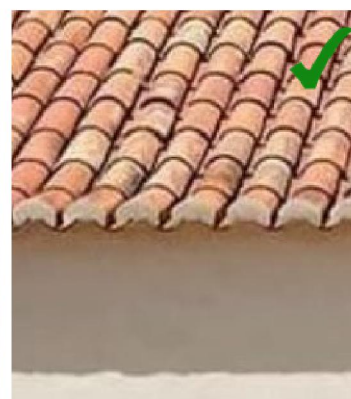
Débords de toiture à l'égout
