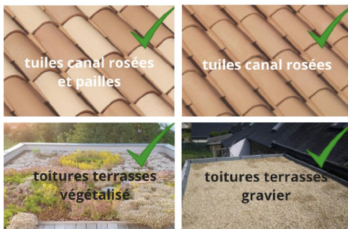
Finitions des toitures
