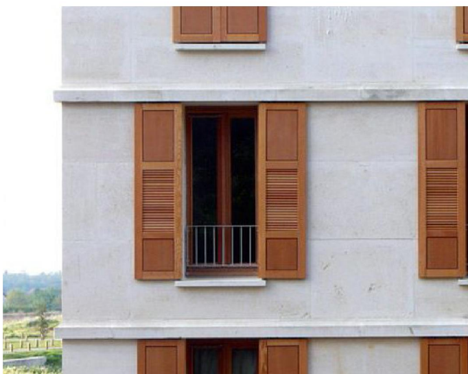
fig.3 Végétalisation des bancons
